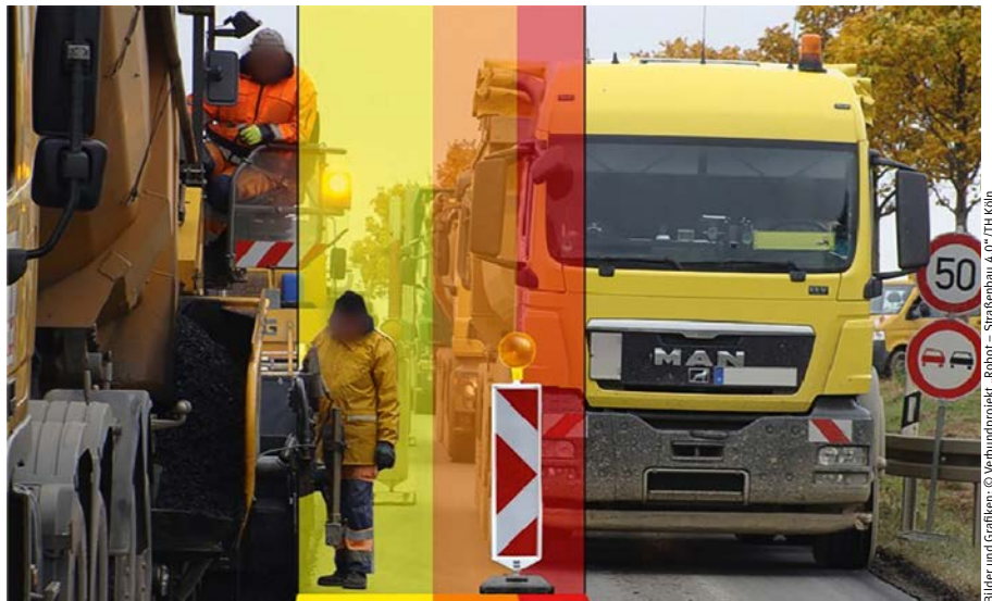
Abb. 1: Dieses Beispiel zeigt den typischen Arbeitsplatz an einer Straßenbaustelle.
